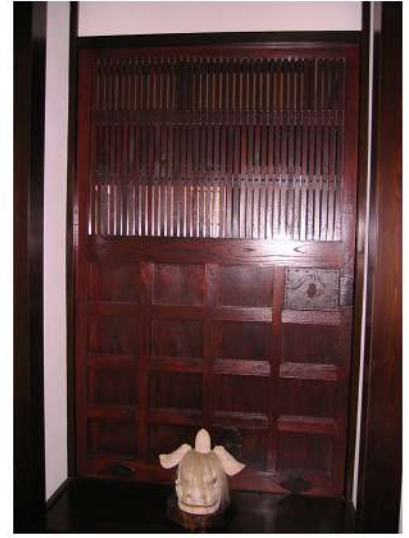
解体した蔵の戸を修復して再利用
